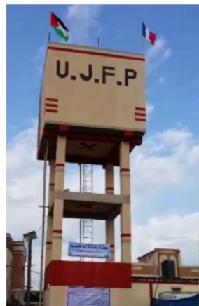
2016 : participer à l'indispensable accès à l'eau. Le château d'eau de Khuza'a alimente par étape une centaine d'exploitations agricoles
