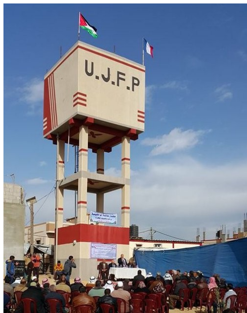
Inauguration (décembre 2016) du château d'eau réalisé grâce au premier appel de fonds coordonné par l'UJFP
