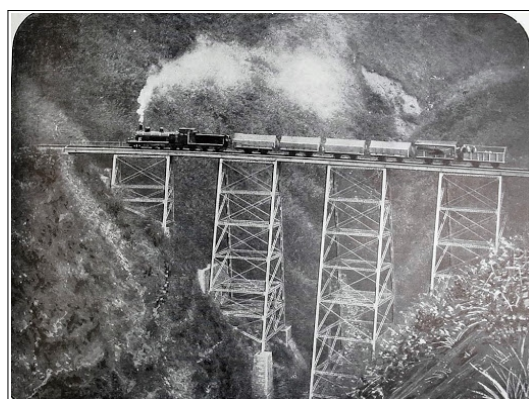
Ouvrage d'art sur la ligne du Chemin de fer du Yunnan.
