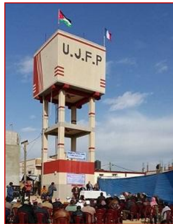
Le château d'eau de Khuza'a. Au sommet flottent les drapeaux palestiniens et français
